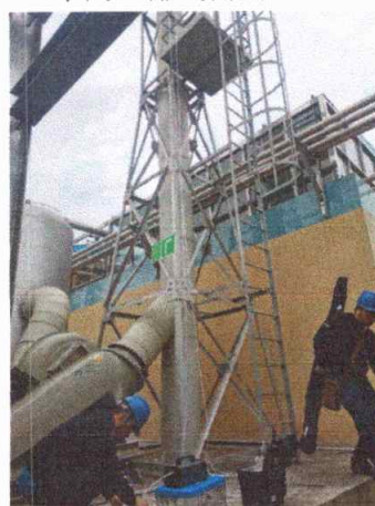
污水处理站排气筒出口 07#
