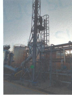
罐区一排气筒出口 05#
