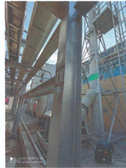
污水处理站排气筒出口 07#
